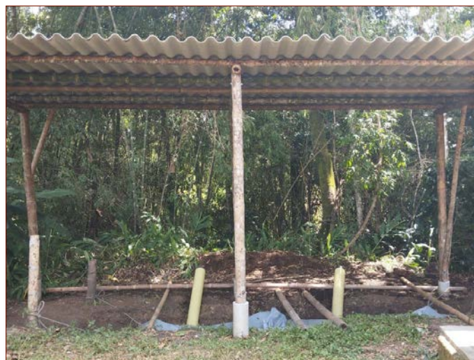
Maßgefertigte künftige Grube / La futura fosa para el biodigestor
